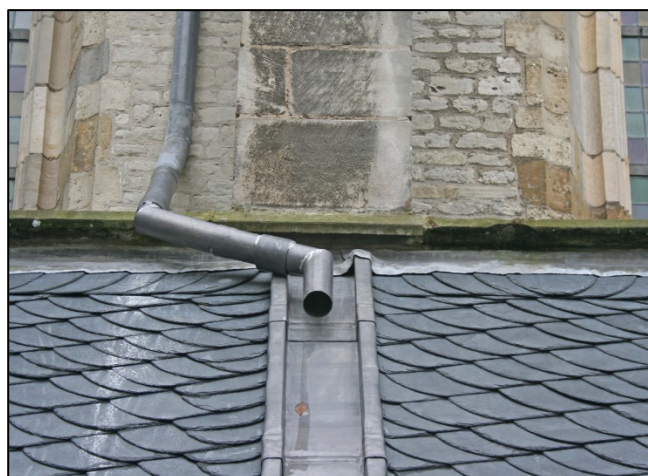
Loden leigoot op een dakvlak gedekt met leien in Rijndekking.
