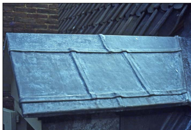
Dakkapel afgedekt met verschervend aangebrachte loodplaten.
