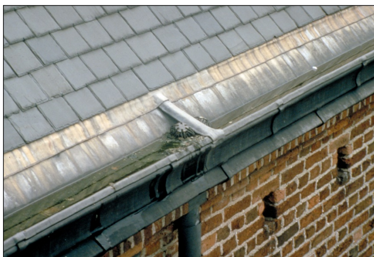
Met lood beklede schampgoot aan de dakvoet van een kerk.
